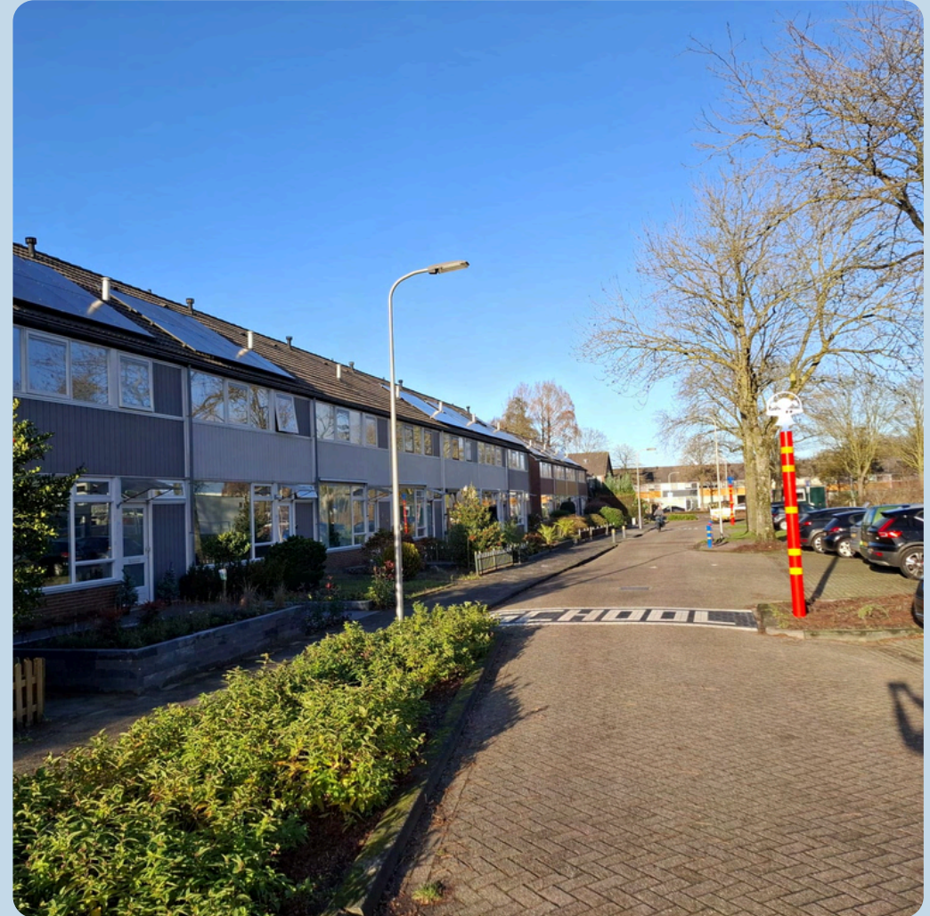
Locatie Esstraat Raalte
